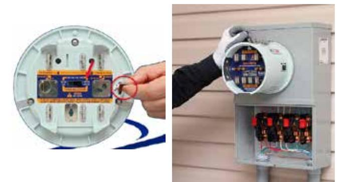
**Fig. 5. Receptáculos de inserción y giro e instalación del sistema de verificación.**
