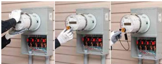
**Fig. 6. Instalación del medidor, el adaptador magnético y el sensor de pulsos.**
