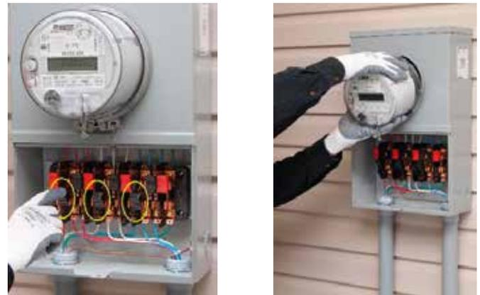
**Fig. 4 Operador cortocircuita los TCs y luego retira el medidor.**
